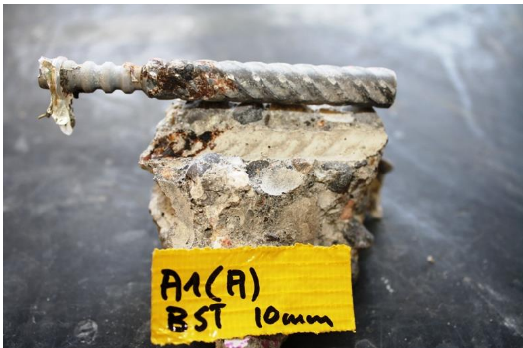
Abb. X-2 Korrosionszustand eines Betonstahls, Überdeckung 10 mm nach dem Ausbau 2012 in der Betonplatte A1.
