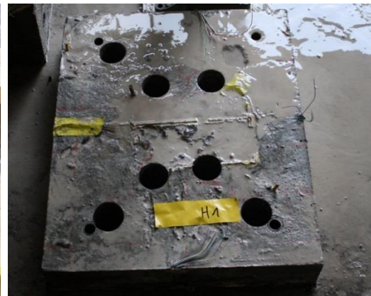
Lage der Bohrkern in Platte H1
