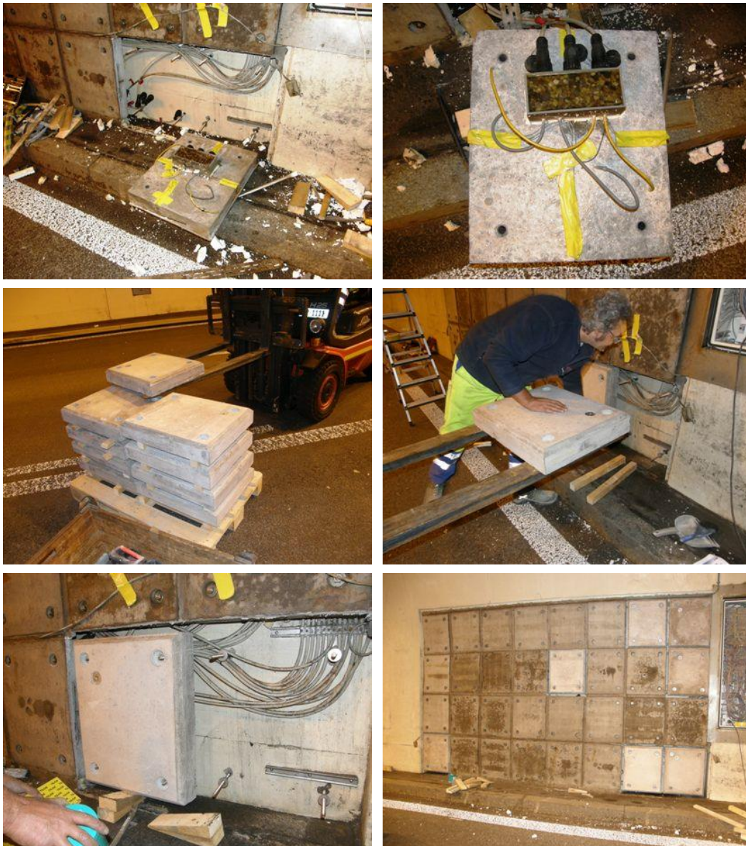
Abb. 12 Plattenausbau / -ersatz am Versuchsstand im Naxbergtunnel. Sieben Platten wurden ausgebaut bzw. ersetzt.
