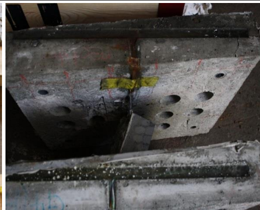
Lage der Bohrkern in Platte H3
