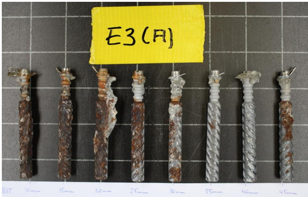
Abb. 39 Korrosionszustand der Betonstähle nach dem Ausbau 2012 in der Betonplatte E3 (Typ A, Beton mit Flugasche). Bewehrungsüberdeckungen von 10 bis 45 mm (Stufen à 5 mm).
