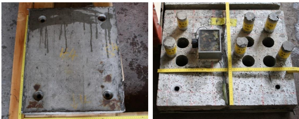
Abb. 14 Bild links: Vorderseite der Platte H4 vor der Probenahme, Bild rechts: Entnommene Bohrkern aus der Platte H4 – Ansicht Rückseite.
